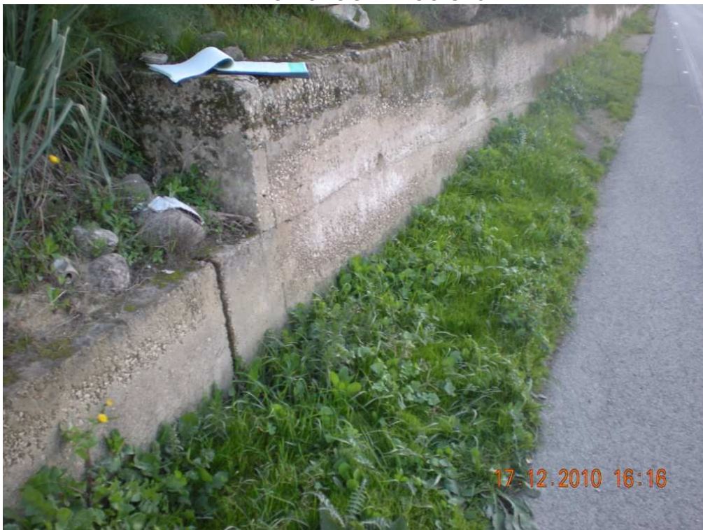
RILIEVO FOTOGRAFICO SX042
