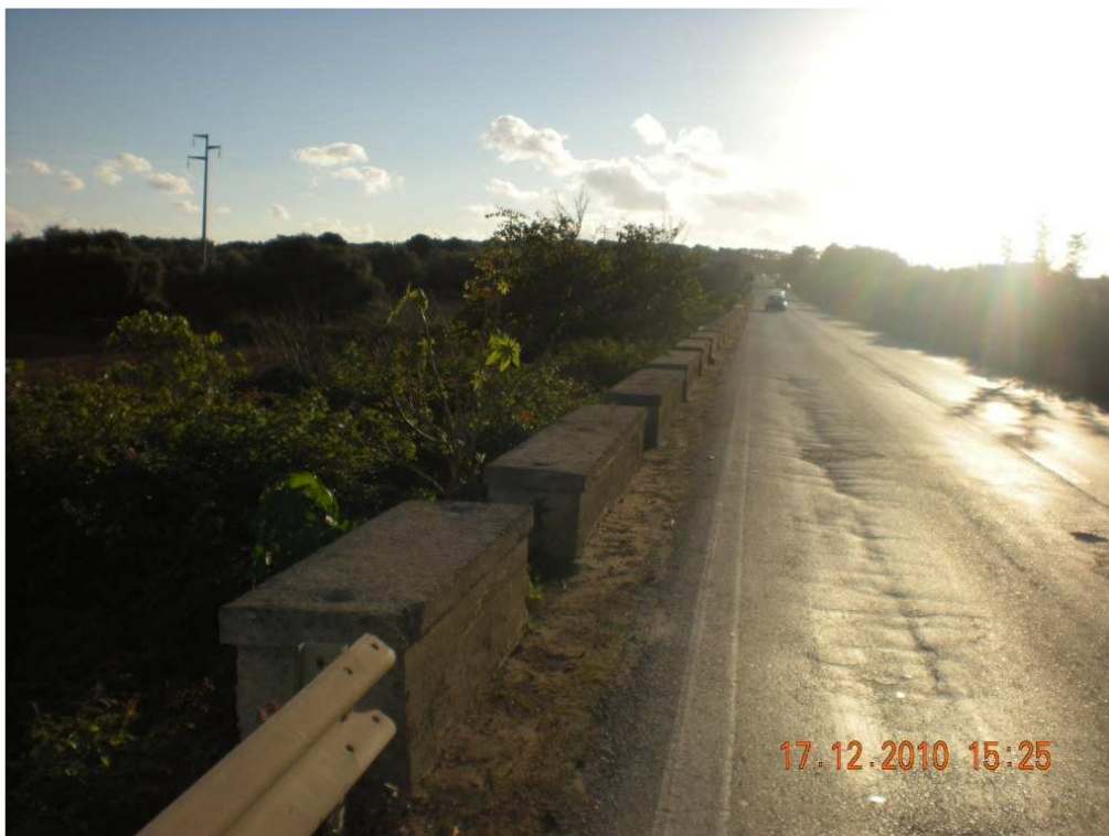
RILIEVO FOTOGRAFICO SX055
