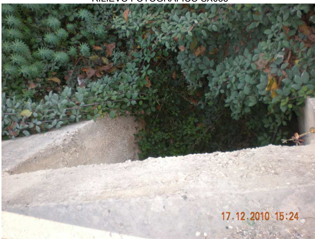
RILIEVO FOTOGRAFICO SX056
