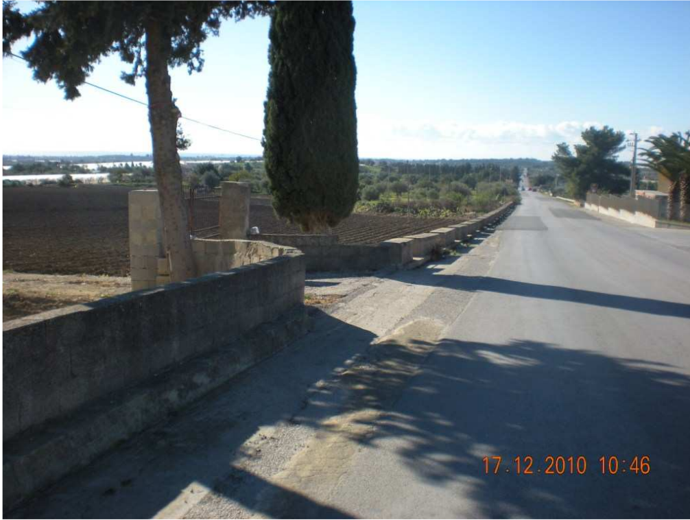
RILIEVO FOTOGRAFICO SX019
