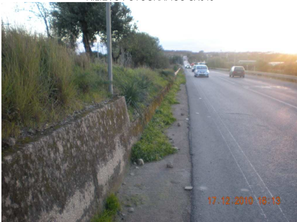
RILIEVO FOTOGRAFICO SX044
