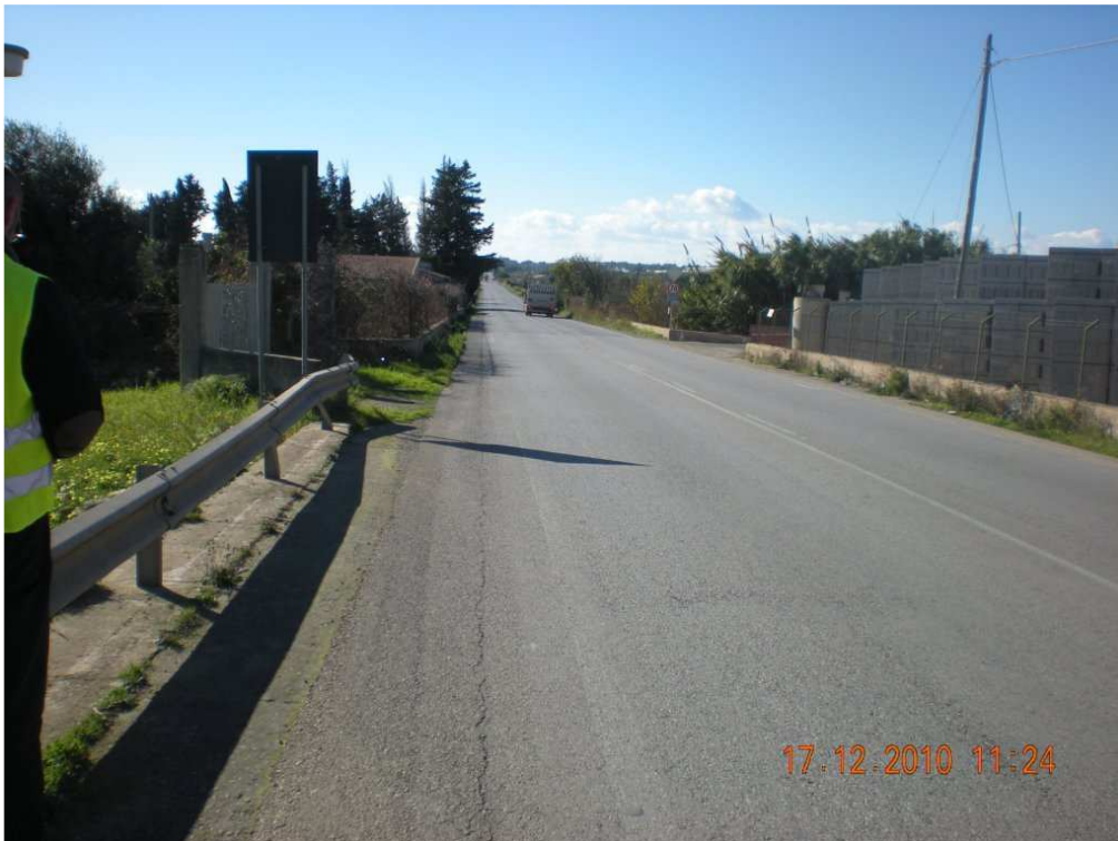
RILIEVO FOTOGRAFICO SX027
