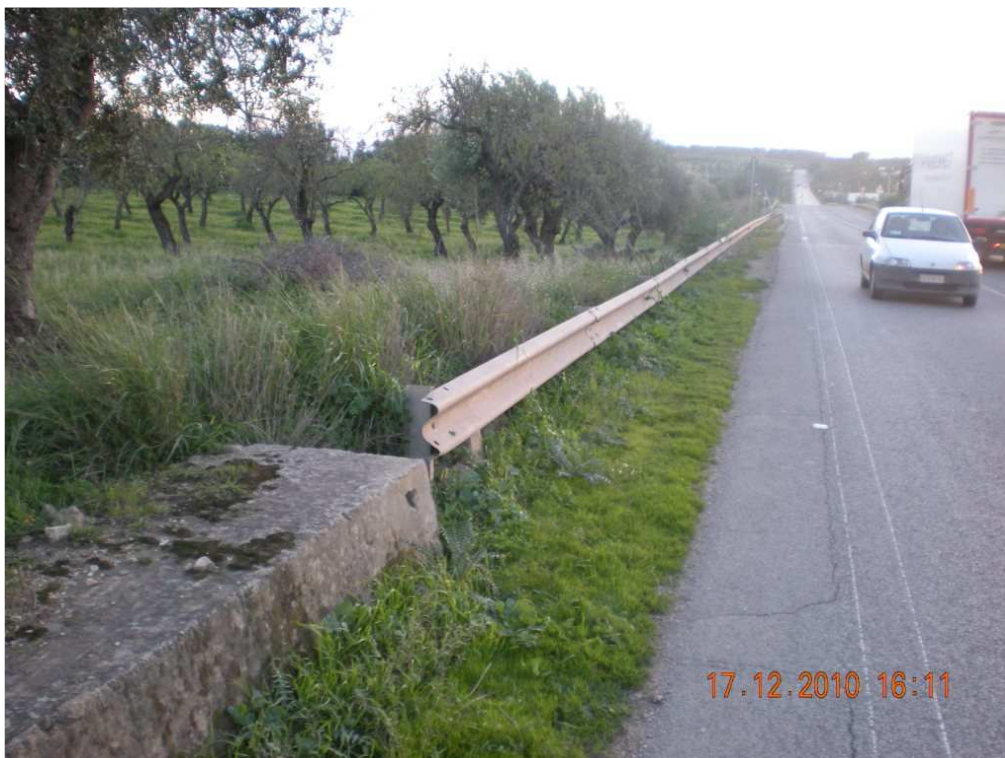
RILIEVO FOTOGRAFICO SX045
