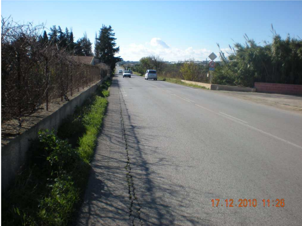
RILIEVO FOTOGRAFICO SX028
