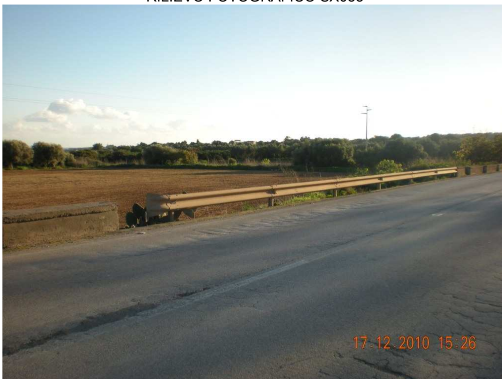
RILIEVO FOTOGRAFICO SX054
