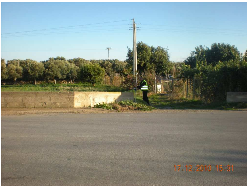
RILIEVO FOTOGRAFICO SX053
