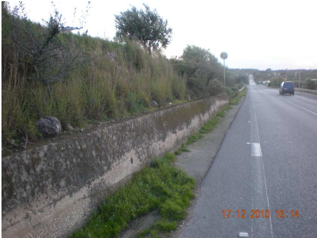
RILIEVO FOTOGRAFICO SX043
