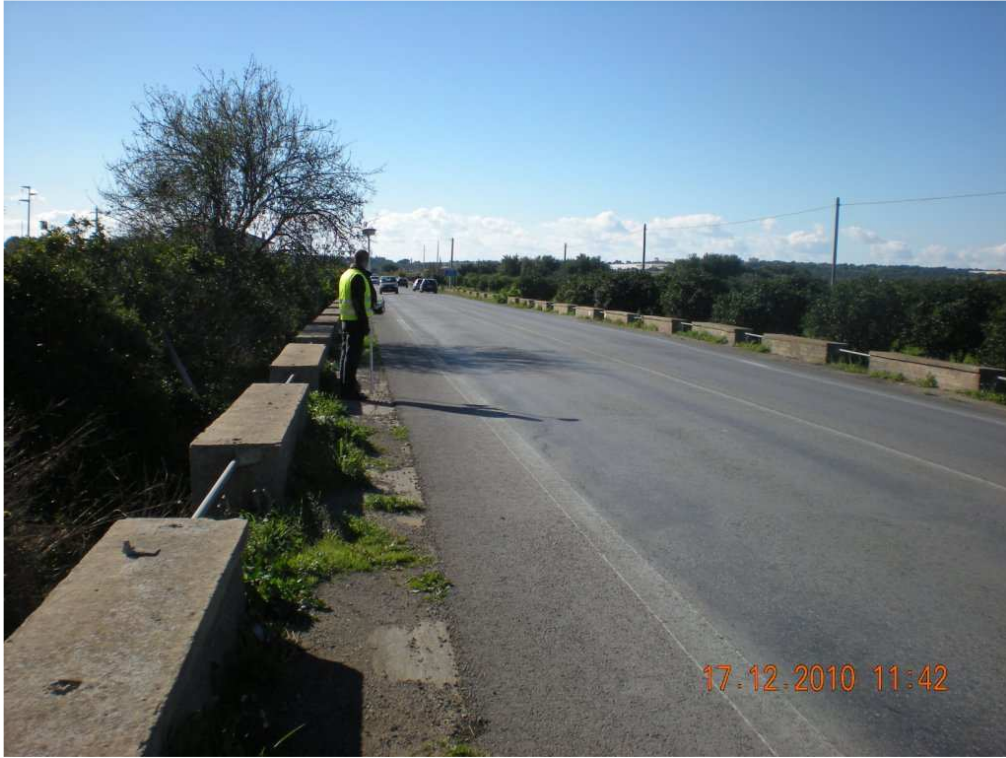
RILIEVO FOTOGRAFICO SX032
