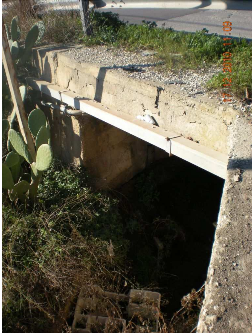
RILIEVO FOTOGRAFICO SX025
