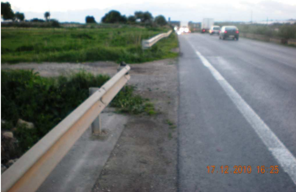
RILIEVO FOTOGRAFICO SX040
