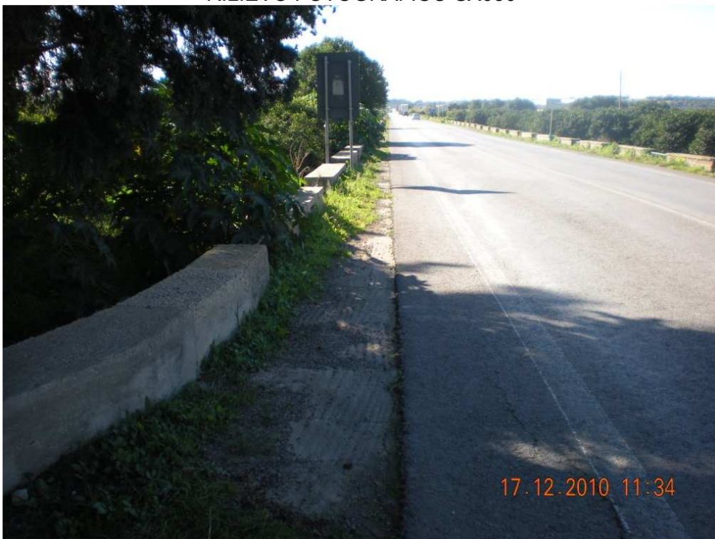
RILIEVO FOTOGRAFICO SX031
