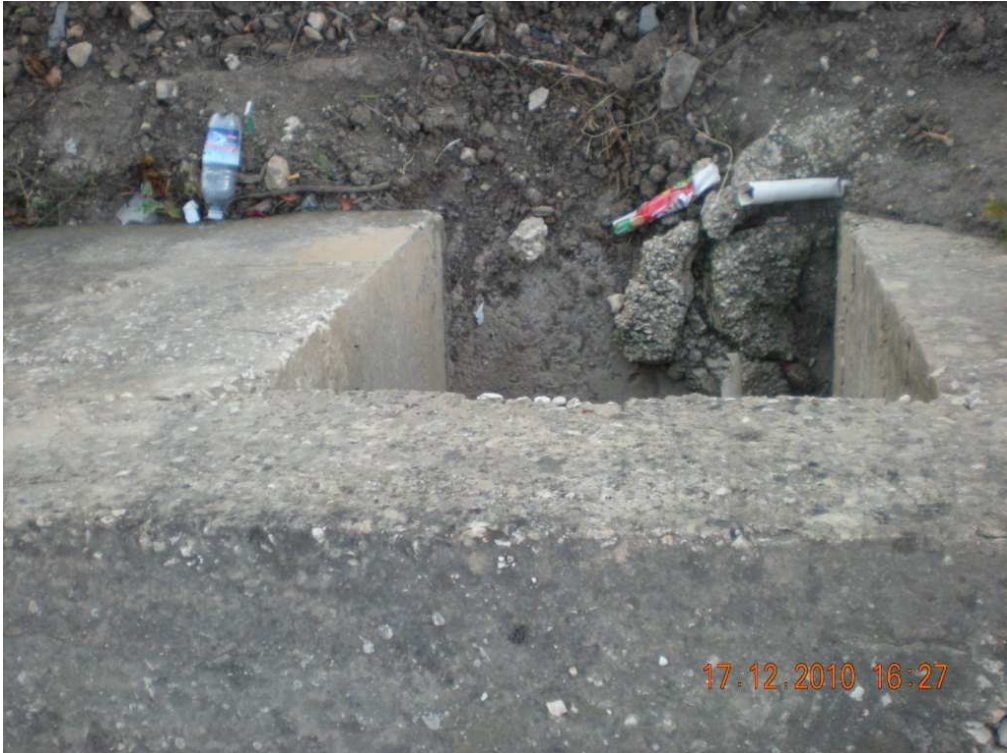
RILIEVO FOTOGRAFICO SX039
