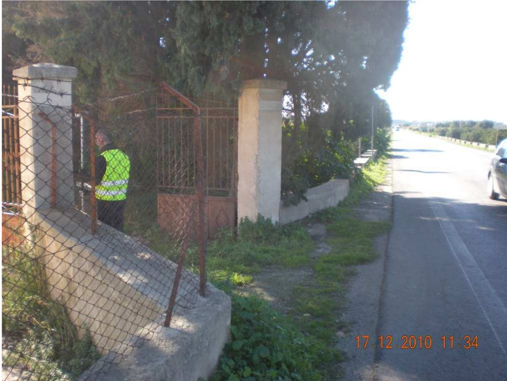
RILIEVO FOTOGRAFICO SX030
