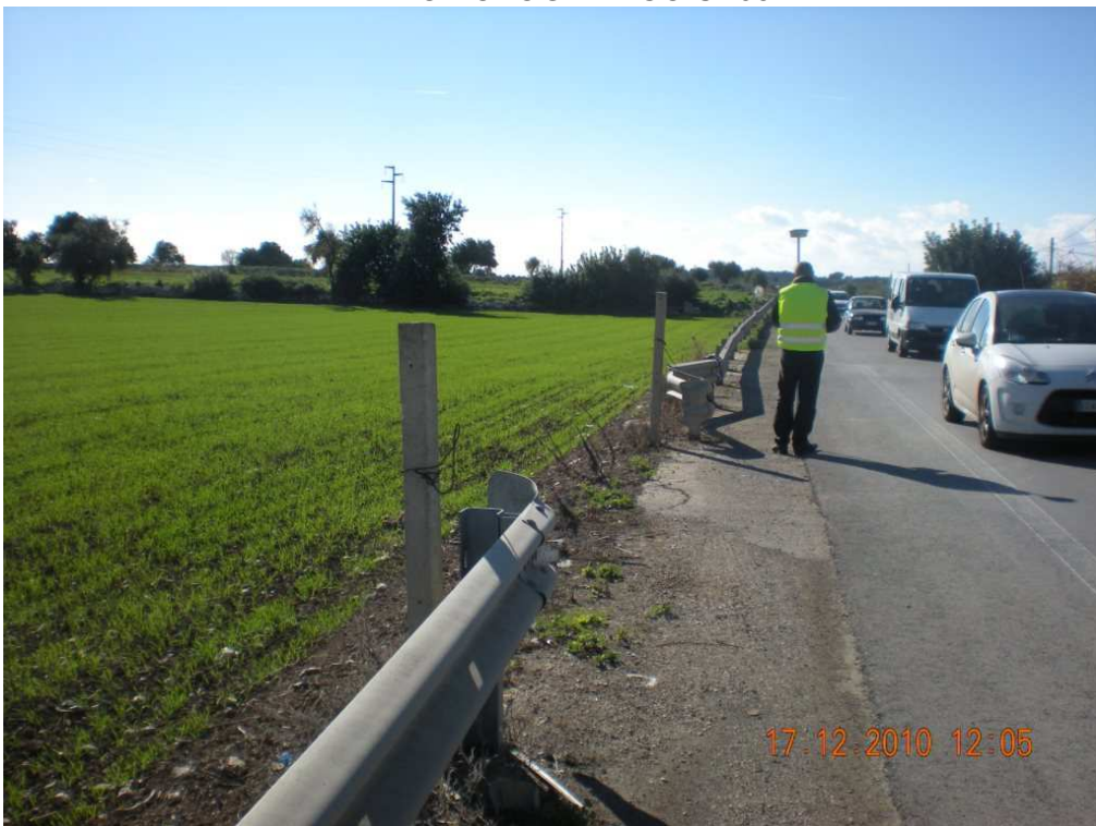
RILIEVO FOTOGRAFICO SX038
