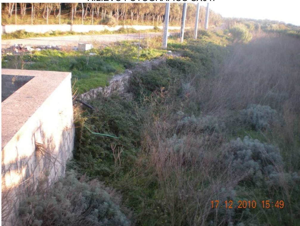
RILIEVO FOTOGRAFICO SX048
