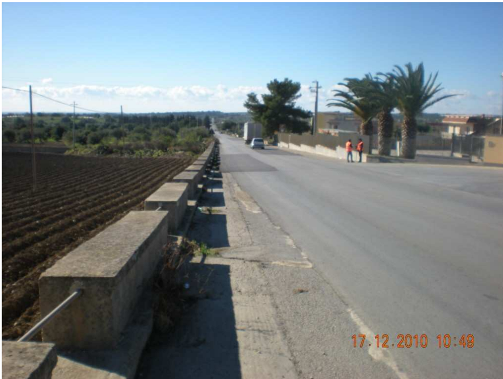
RILIEVO FOTOGRAFICO SX020
